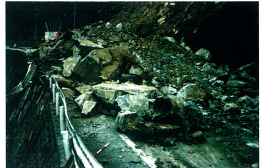
写真-3.8 急斜面崩落による道路災害 (1990年3月、京都府宇治田原町)
