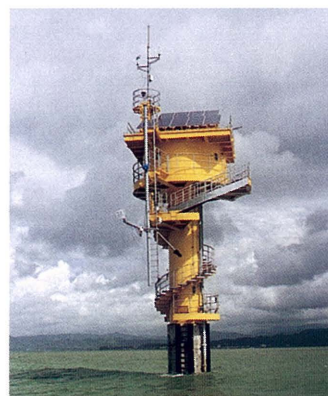
白浜高潮観測塔
