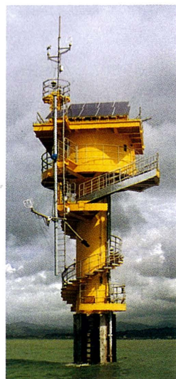
写真-3.17 白浜高潮観測塔
