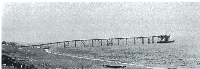
観測用大栈橋
