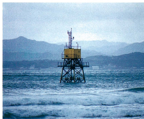
写真-3.16 白浜海洋観測塔
