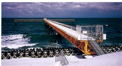
写真-3.20 波浪・漂砂観測専用観測栈橋 (昭和61年～現在)
