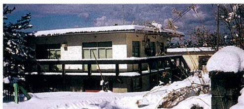
写真-3.19 観測所本館（昭和56年竣工）
