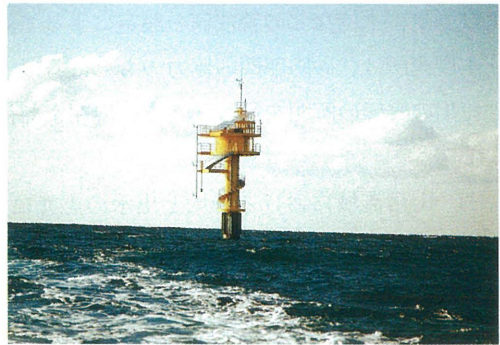
写真-2.14 田辺・中島高潮観測塔
