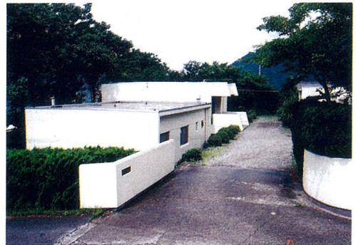
写真-2・16 徳島地すべり観測所本館
