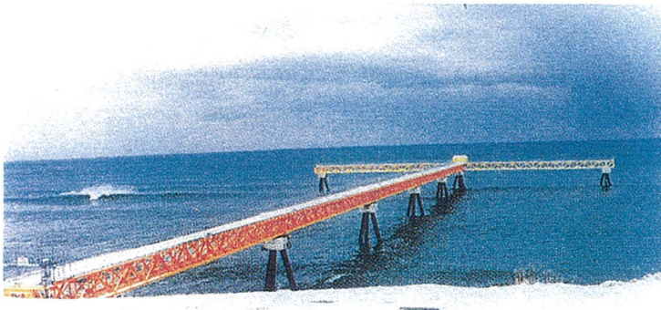
写真-2.17 波浪・漂砂観測栈橋
