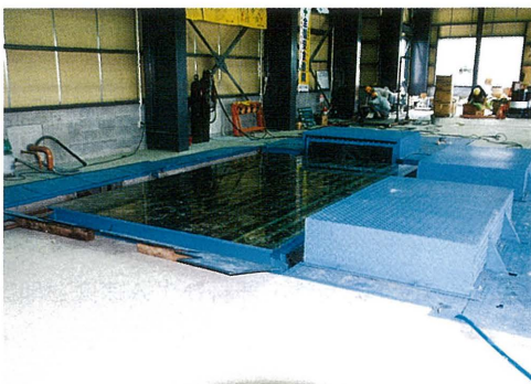
写真-2・1 分散並列型強震応答実験装置（3軸振動台）
