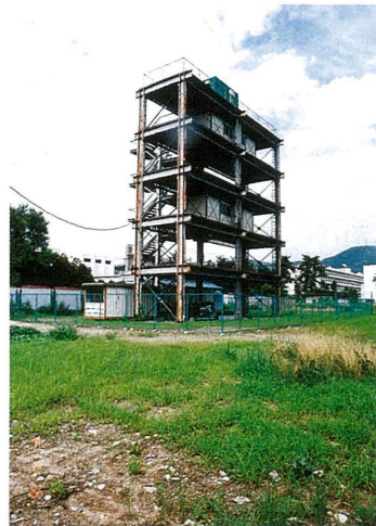
写真-2・2 鋼構造5階建て試験架構による応答制御実験
