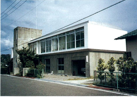
写真—2.13 白浜海象観測所本館
