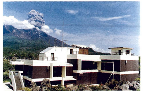
写真—2.12 桜島火山観測所本館
