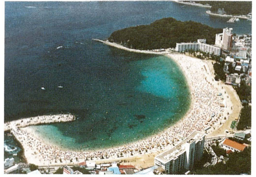
写真—3.12 安定海浜工法の適用 (白良浜)
