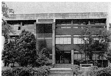
写真-2-44 防災科学資料センター
