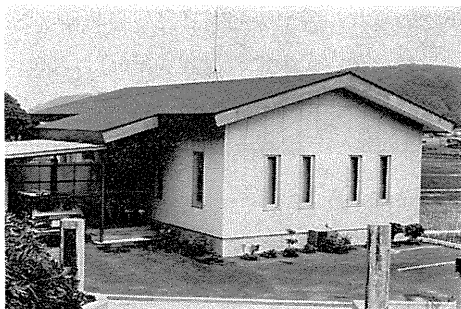
写真-2-21 分館（テレメーター送受信室）
