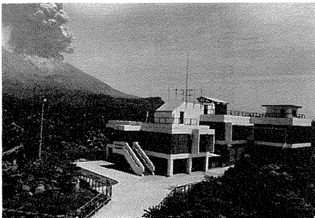
写真-2・19 桜島火山観測所本館
