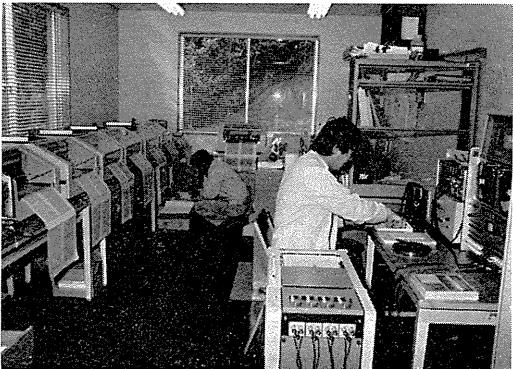
写真-2・12 テレメーター集録室内部（鳥取）
