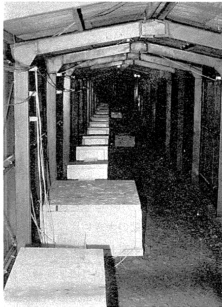
写真-2・14 蔵柱観測坑
