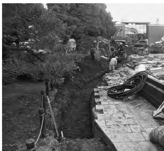
6 地点36全景（北から）
