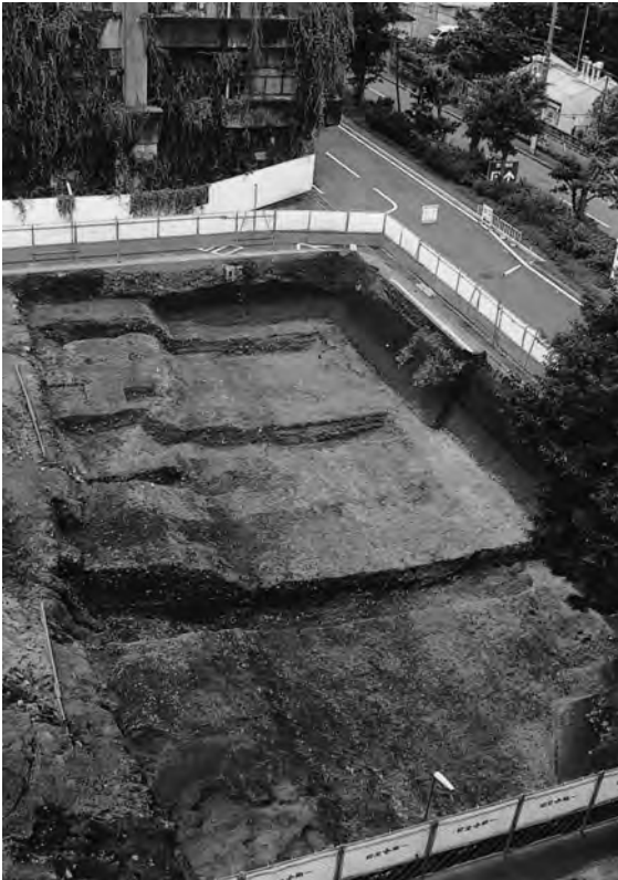
2 S R215断割状況（北から）
