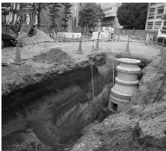
5 地点27-e 地点付近全景（南東から）
