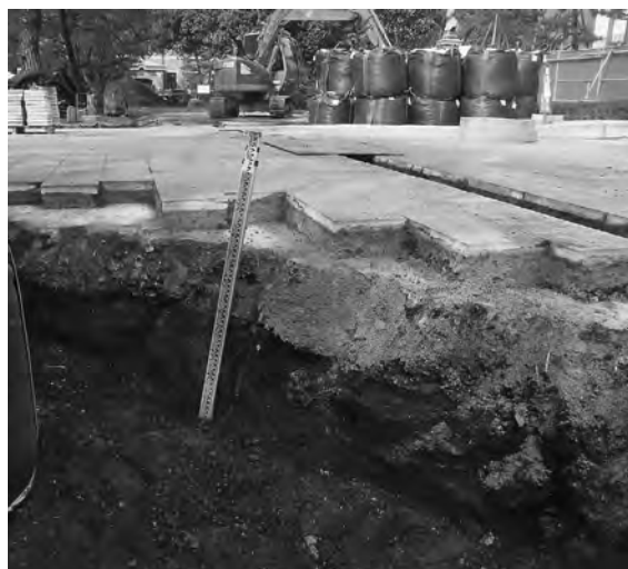
2 地点37-p 地点灰褐色土落ち込み検出状況（東から）
