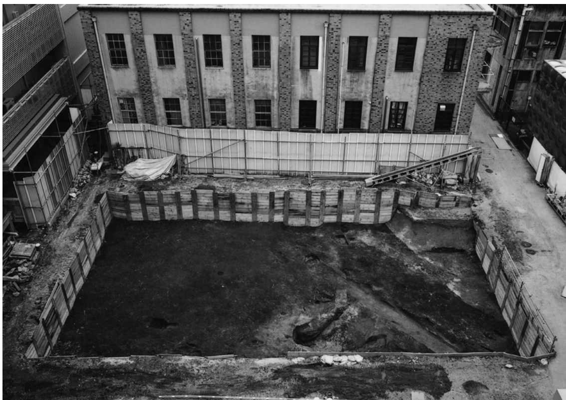
1 I期調査区, 黄色砂除去後の全景 (北から)
