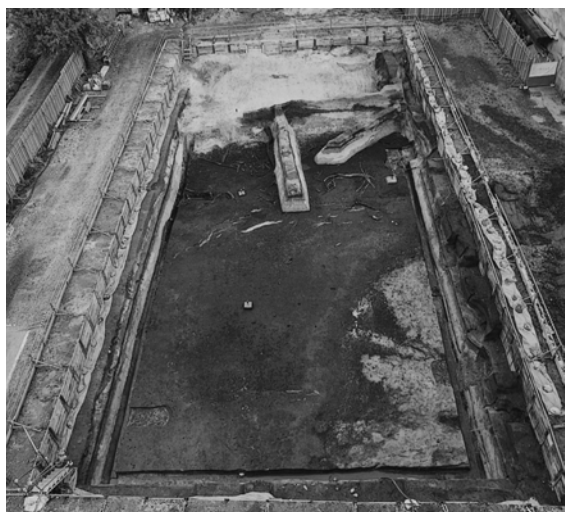
1 腐植土I除去後の全景（西から）
