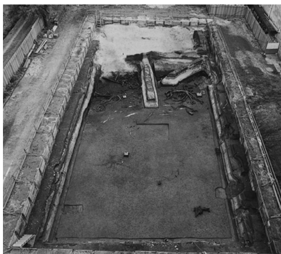
3 青灰色粘土掘削終了後の全景（西から）
