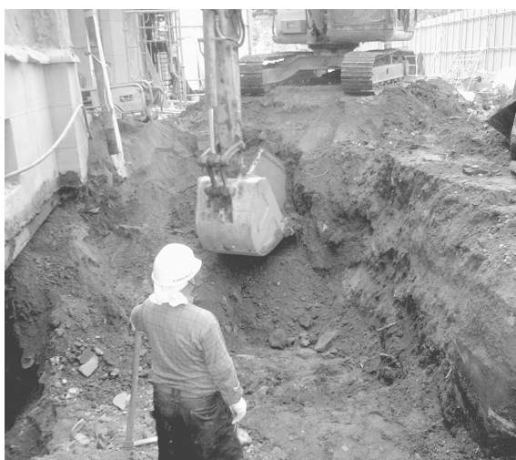
3 329b 地点掘削状況（東から）
