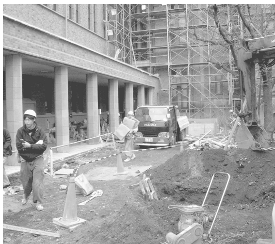
3 329 e ・ 336 a 地点付近全景（南から）
