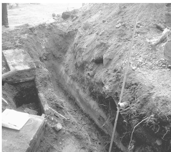
4 329b 地点掘り上げ状況（東から）
