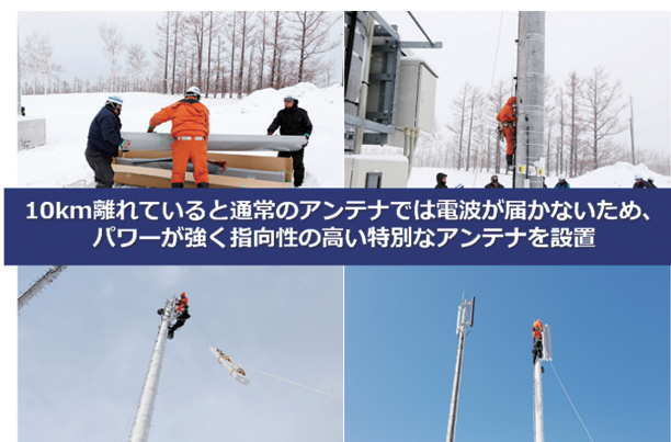
図3：知床対策におけるアンテナ設置作業の様子
