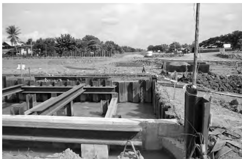
チャオプラヤ川沿いバーンチョームシー水門の改修現場。2011年大洪水による破壊の後、全面的に設計を見直した再建工事が進められている(2012年9月20日撮影)
