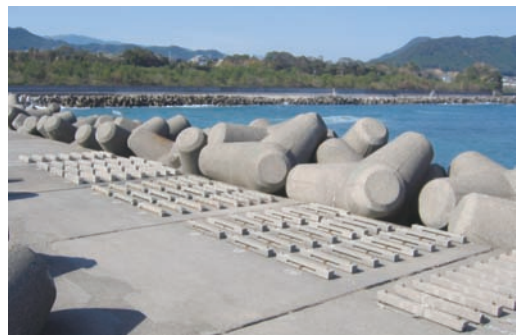
図-1 鉄筋コンクリート供試体の実海洋暴露実験
