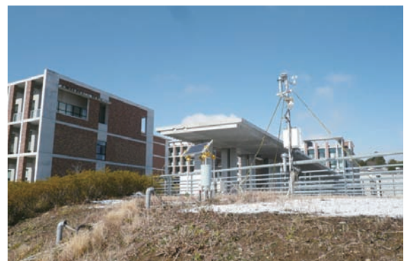
図-8 桂キャンパスCクラスターの人工斜面に設置した気象観測装置と土壌水分観測装置
