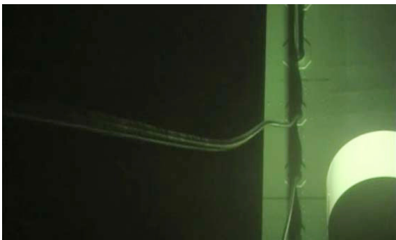
図-4 斜張橋ケーブルのレインパイプレーション
