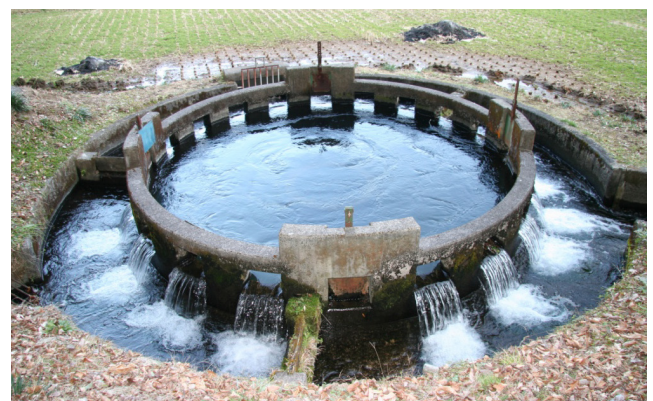
写真-1 円筒分水工（大分県竹田市、音無井路十二号）
