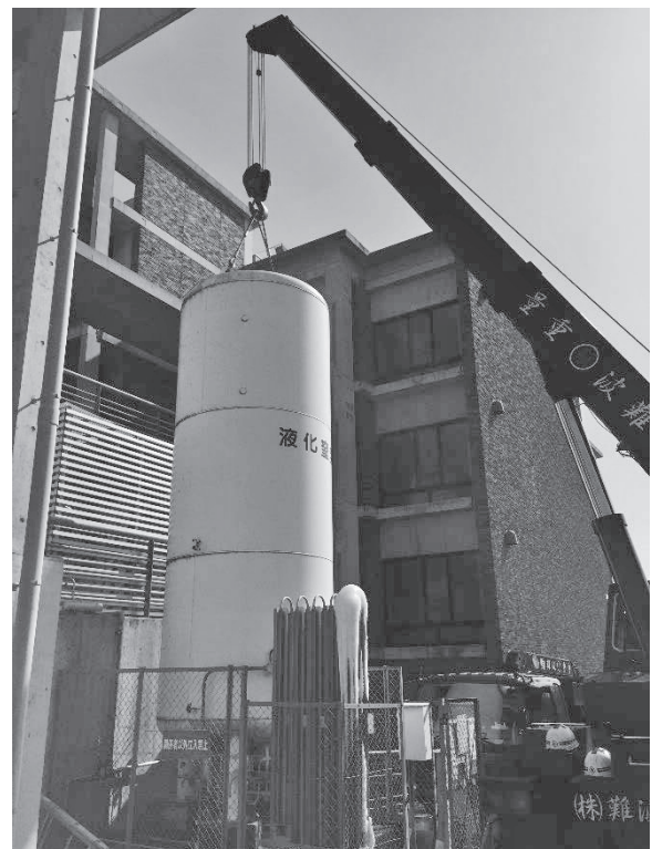
図3. 転倒防止措置として、液化窒素CEをクレーンで保持した様子。
