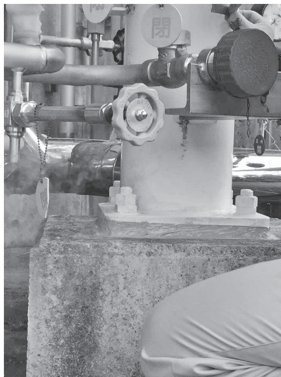
図4. 液化窒素CEの脚部の隙間にシリコンコーキング材を充填した様子。
