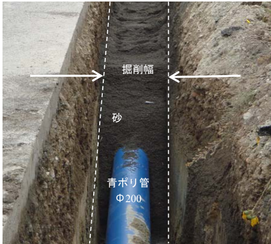
写真-4.18 現場埋設状況
