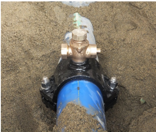
写真-4.10 給水分岐 \phi 100 \times 20
