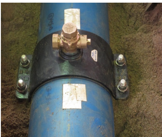
写真-4.12 給水分岐 \phi 200 \times 20
