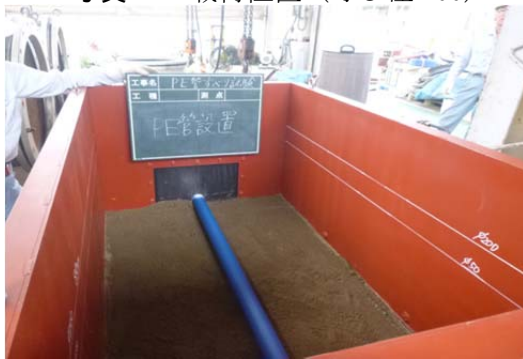
写真-4.3 管設置状況（呼び径 50）
