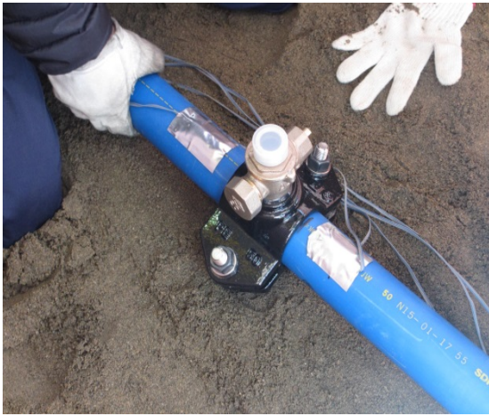
写真-4.8 給水分岐 \phi 50 \times 20
