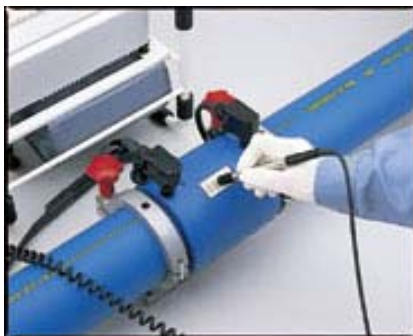
写真-2.1 融着接合状況
