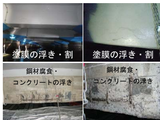
写真 4.1 施工前の状況 (施工箇所 No. 2, 側面-1)
