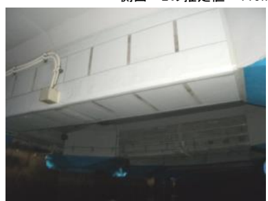
No. 1 : 貼付け型シート陽極 間欠通電
