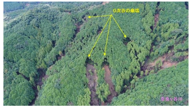
図-6-1 多発した谷頭(0次谷)での崩壊
