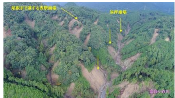
図-6-2 溪岸崩壊と尾根まで達した表層崩壊
