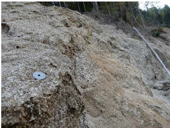
図-6-4 マサ土とサプロライトの境界付近で発生した表層崩壊
