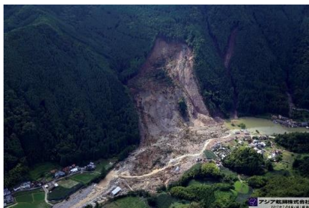
図-5-1 小野地区地すべり地全景(アジア航測(株) 2017年7月9日撮影)
