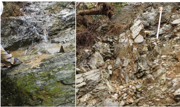
図-2-7 重力変形していない泥質片岩（左）と重力変形によって座屈した泥質片岩（右）
