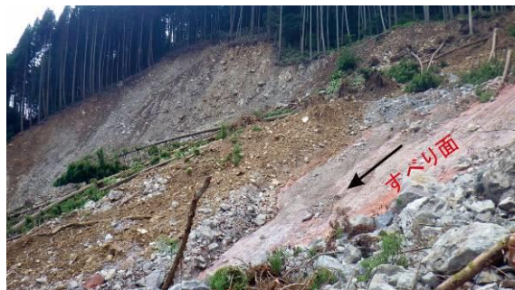
図-5-3 上部ブロックに露出したすべり面
