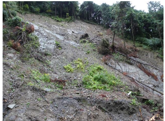
図-6-10 流れ盤構造の片理面をすべり面とした表層崩壊
