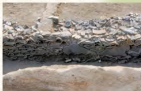
築地塀につかわれた瓦積。徳島藩邸跡のものと考えられている
