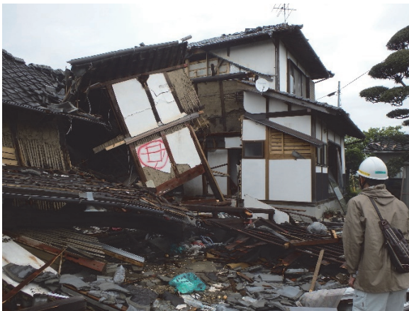
写真2：旧耐震の木造住宅の倒壊の様子1
