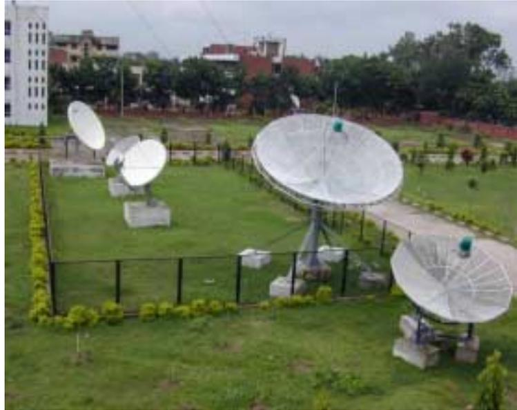
第5図 気象衛星の受信アンテナ
