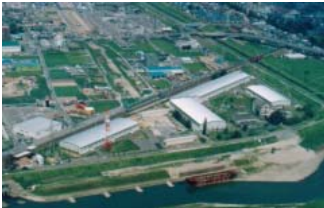
新実験棟完成 (平成 10 年秋) 後の実験所全景
