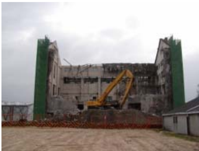
解体工事中的本館(2003.3.5 現在)
