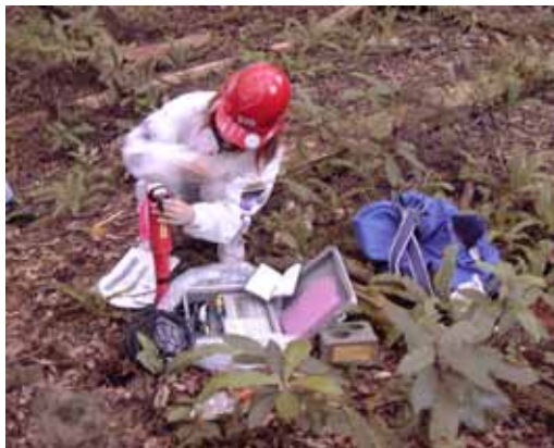
写真6 設置作業状況
