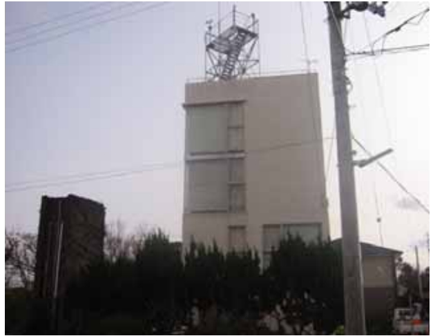
写真2 潮岬風力実験所研究室本館
