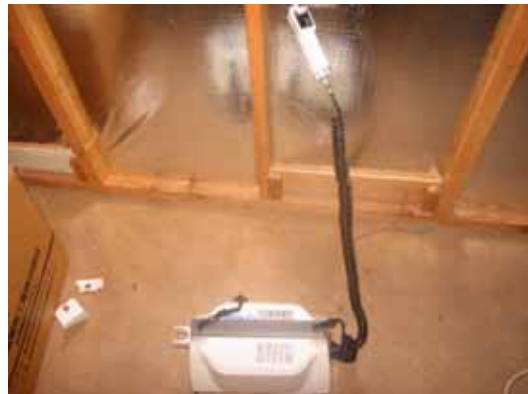
写真6 コンプレッサーとノズル
