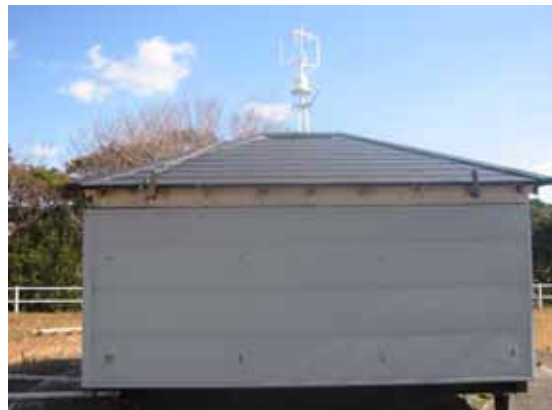
写真4 瓦飛散観測のための家屋
