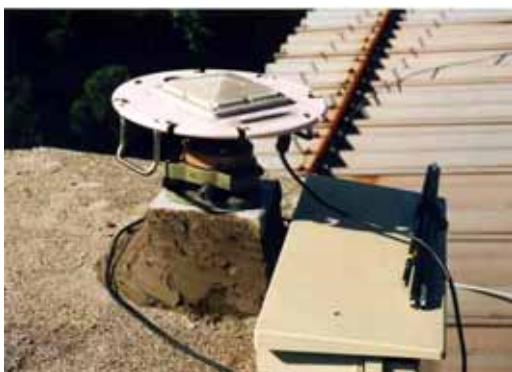
写真25 アンテナ設置状況
