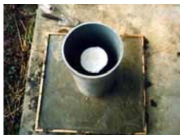
写真8 ベースと柱部分
