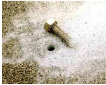
写真5 埋め込み穴とボルト
