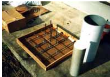
写真7 アンテナ架台基礎
