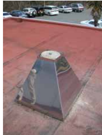
写真 28 アンテナ架台カバー
