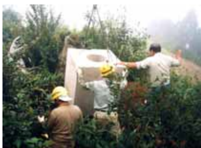
写真 14 コンクリート枡
