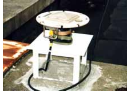
写真 11 アンテナ取り付け状況
