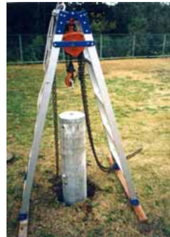
写真 22 建柱作業
