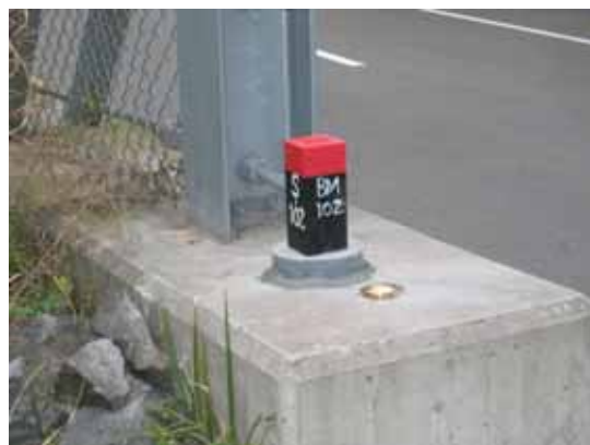
写真 3 新水準点の設置
