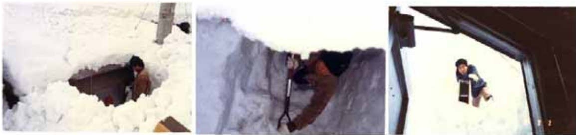
写真18 今庄送信室の点検。屋根から下の入り口へと除雪して行く
