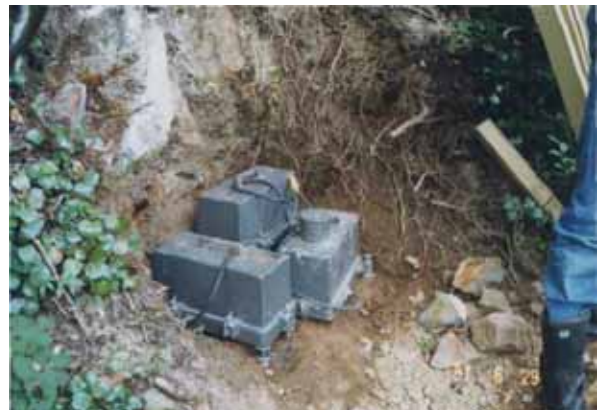
写真10 山肌で岩を掘り出して設置
