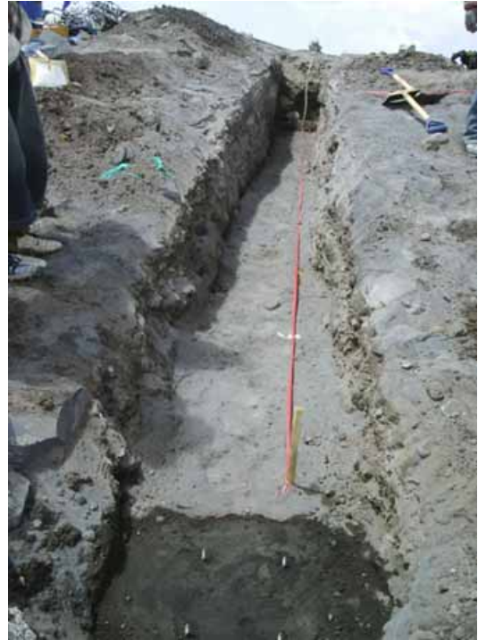
写真4 水管傾斜計設置用の穴
