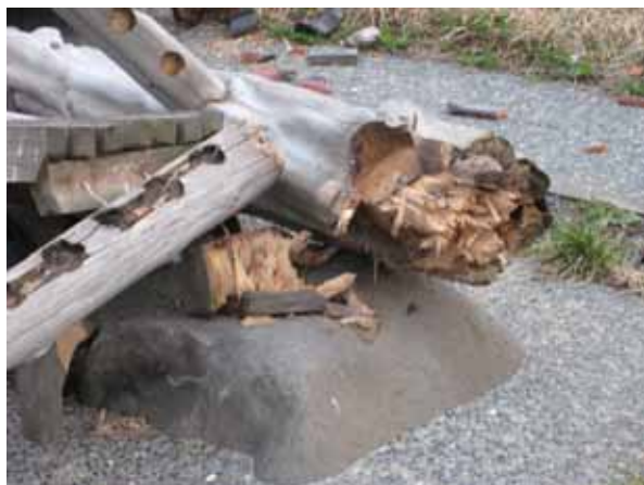
写真9 2007年の能登半島地震による建物倒壊現場
