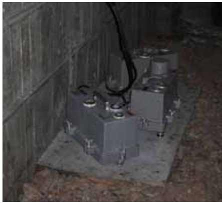
写真4 上宝観測坑道に設置されているPK-110型(勝島製作所製)地震計
