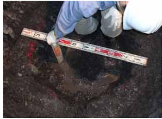
写真 15：ひずみ計設置穴
