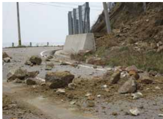
写真1 落石により通行止めとなっている。
