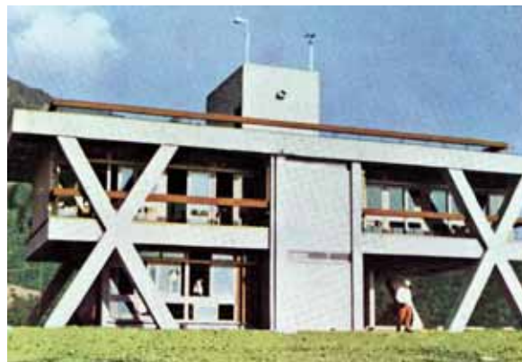
写真 2 ハルタ山観測所
