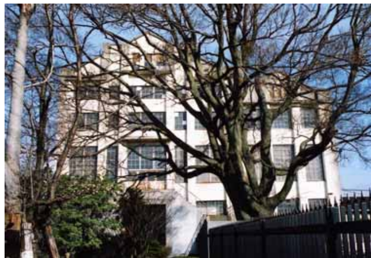
取壊し直前の旧本館
