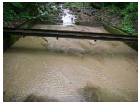
写真 2 試験堰堤土砂出し前
