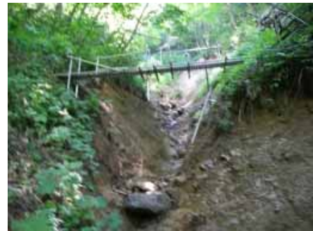
写真 1 新しく作成した橋
