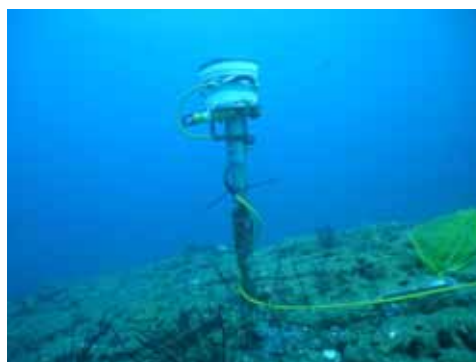
写真4 ADCP 設置完成写真
