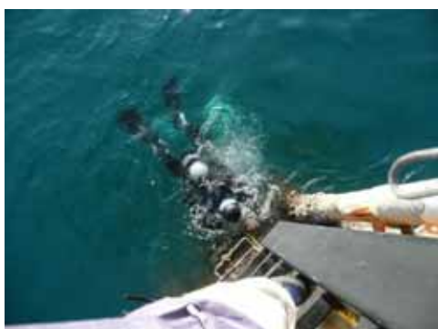
写真3 観測塔へのケーブル固定作業
