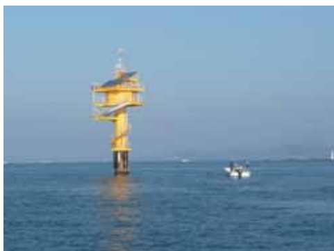
写真1 観測塔付近での作業風景
