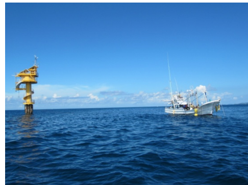
写真 5 : 観測塔と作業船
