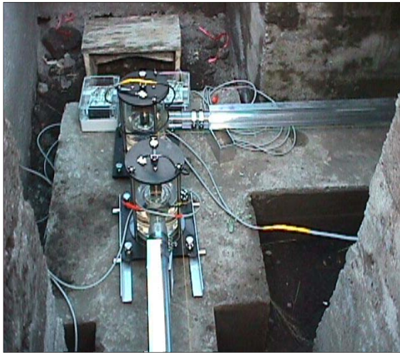
● トレンチ観測壕：2成分センサー部
