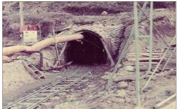
● 掘削中の宮崎観測所坑道
