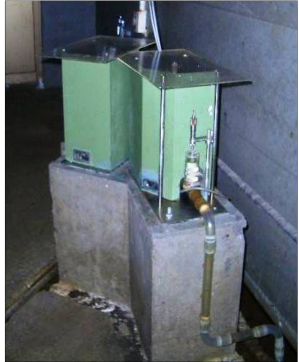
● 宮崎観測所坑道：水管傾斜計W1A/W3B
