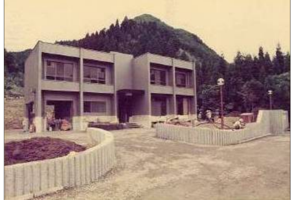
● 工事中の宮崎観測所観測所本館
