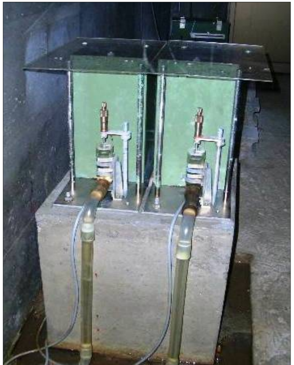
● 宮崎観測所坑道：水管傾斜計W1B/W2A
