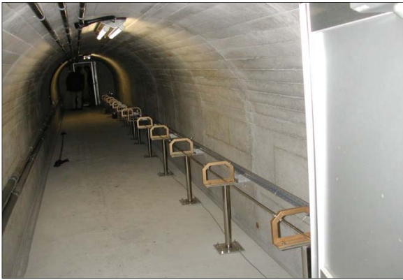
● 大隅観測室支柱群：園田支柱溶接で製作
