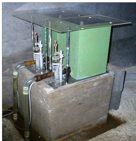
● 宮崎観測所坑道：水管傾斜計W1 B/W2 A
