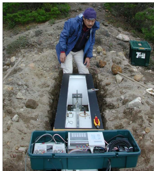
● 埋設型ハーフフィールド傾斜計の設置状況
