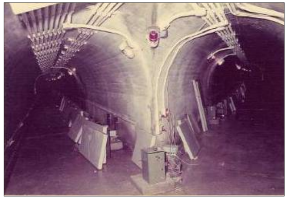
● 完成した観測坑道中央付近
