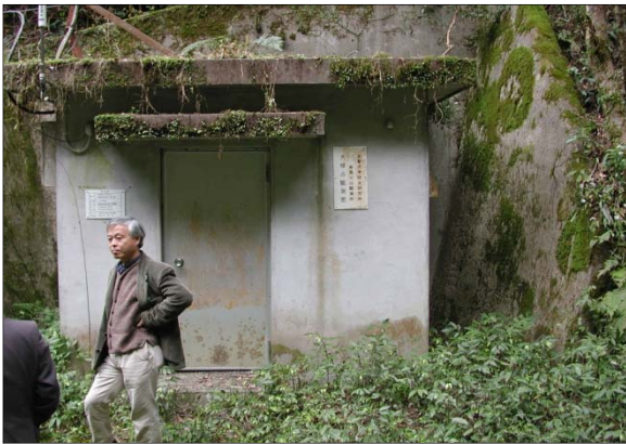
● 大隅観測室正面
