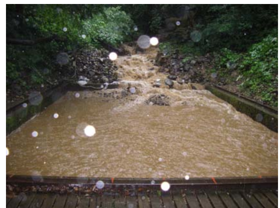
写真 6 ヒル谷試験堰堤
