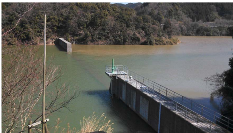
写真3. 布目ダム副ダムの様子
