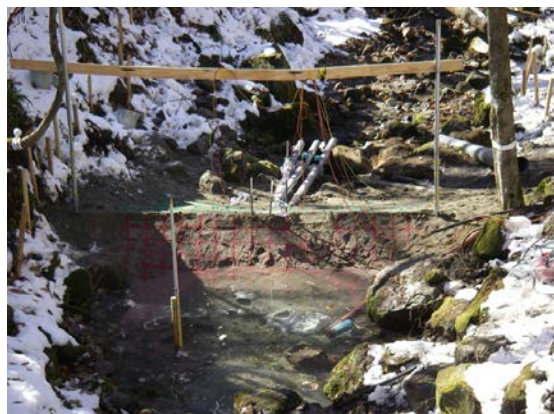
写真 2. 天然ダム実験開始時の状況
