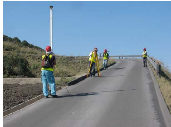
図2. 水準測量時の標準的な班構成
