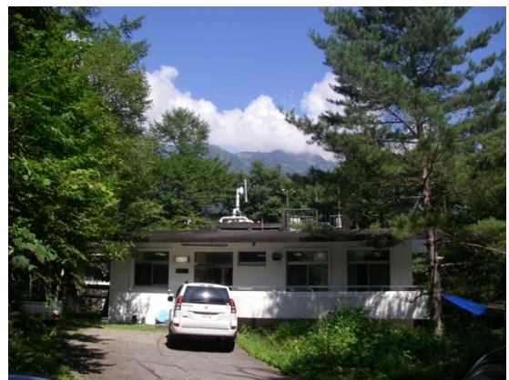
写真1. 穂高砂防観測所
