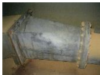
写真2 錆を落とした様子
