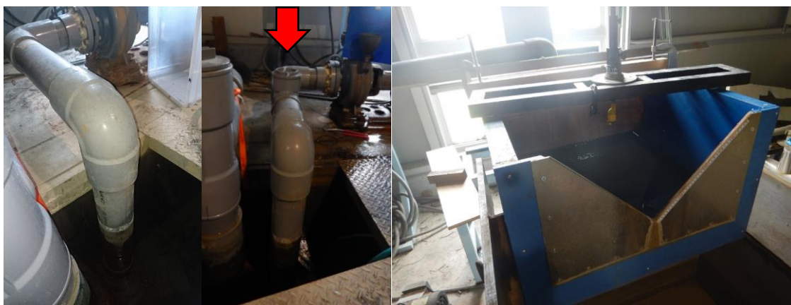
写真1 ポンプ配管前（左）後（右）
