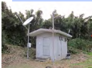
諏訪之瀬島観測室
