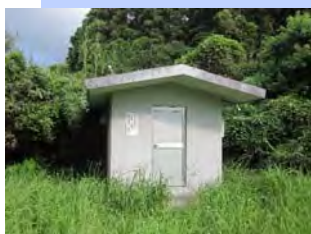
口永良部島観測室
