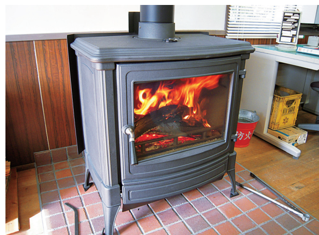
事務室と職員の心を温めてくれる薪ストーブ
