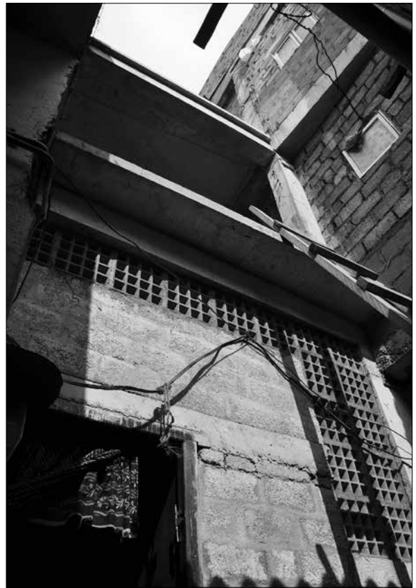
図9 完成した構造体
