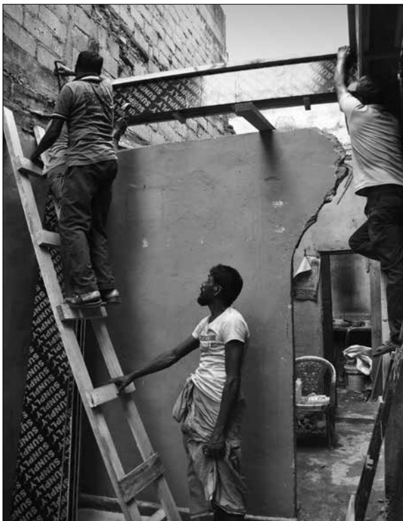
図8 RC柱列の建設
