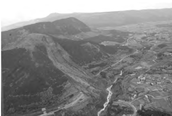
写真 1 阿蘇大橋の地すべり (朝日新聞社機より福岡が撮影)
