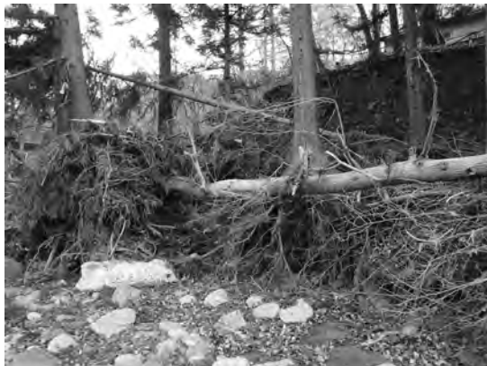
写真-2 河岸侵食によって根が露出したスギ
