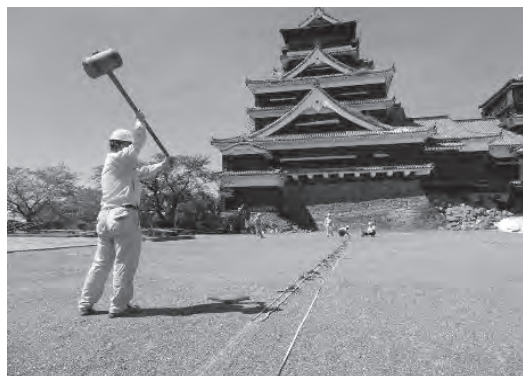
写真-3 表面波探査の実施状況 (本丸, 測線7)
