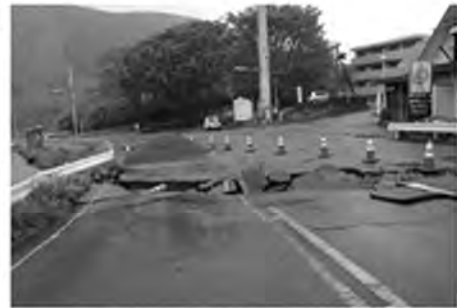
写真12 南阿蘇村河陽の右横ずれ変位
