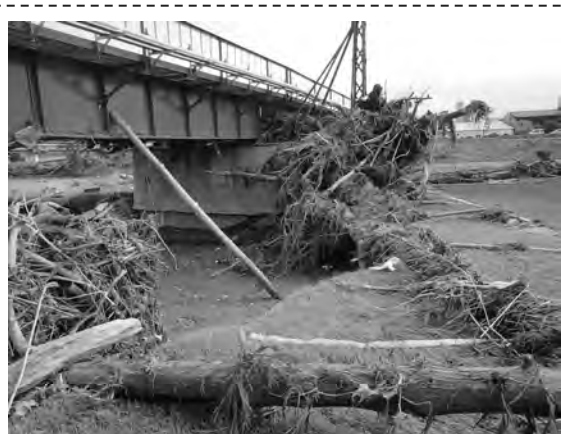
写真-1 久慈川鉄道橋の流木堆積 (2016年9月2日撮影)
