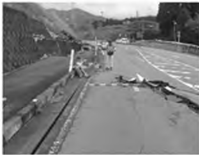
写真10 西原村大切畑の断層変位
