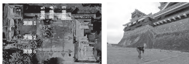
図-9 平左衛門丸での表面波探査の測線配置
