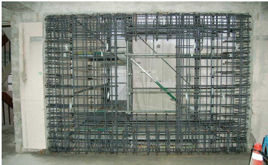
補強構造壁配筋状況 (通常より数量が多い。2階 研究室3 北側外壁)
