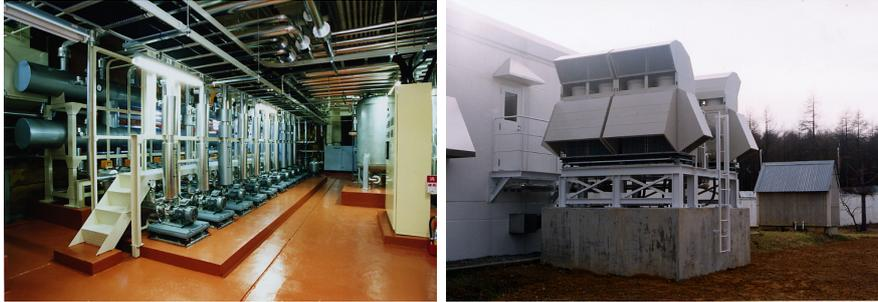
(左) 塔体冷却システムの機械室 (右) ブラインチラー (冷凍機)
