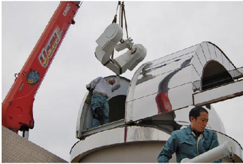
写真 1 : 飛驒天文台での FMT 解体作業
