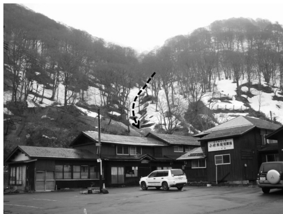
写真-4 被害を受けた旅館と雪崩斜面の様子(2018年4月16日)。写真中の破線矢印が推定される雪崩走路である。なお、雪崩発生面は確認されていない。
