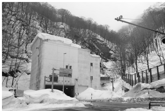
写真-5 仙岩トンネルの様子(3月9日撮影)。仙岩トンネル右側の斜面を雪崩が通過した。
